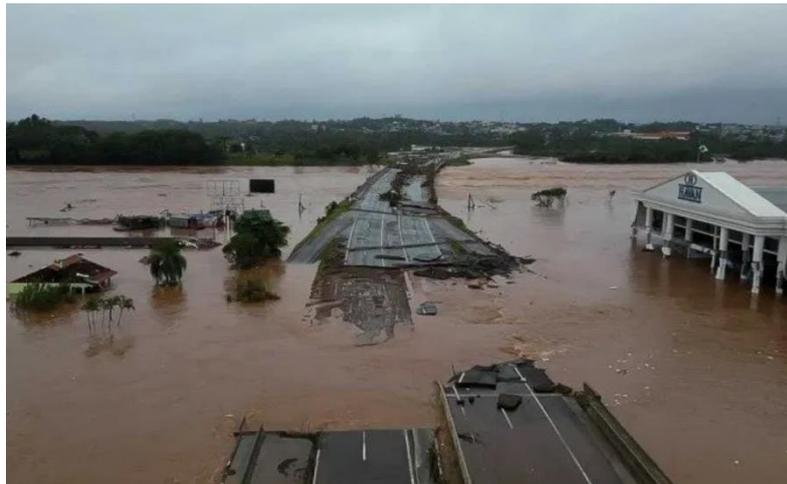
Em Lajeado, a força das águas do Rio Taquari durante a enchente causou a destruição de um trecho da BR-386, principal via de acesso à cidade. A ponte que ligava Lajeado ao município vizinho de Estrela foi gravemente danificada, com o asfalto sendo arrancado e a estrutura comprometida. A cidade ficou totalmente isolada. Fonte: AFP (2024)
